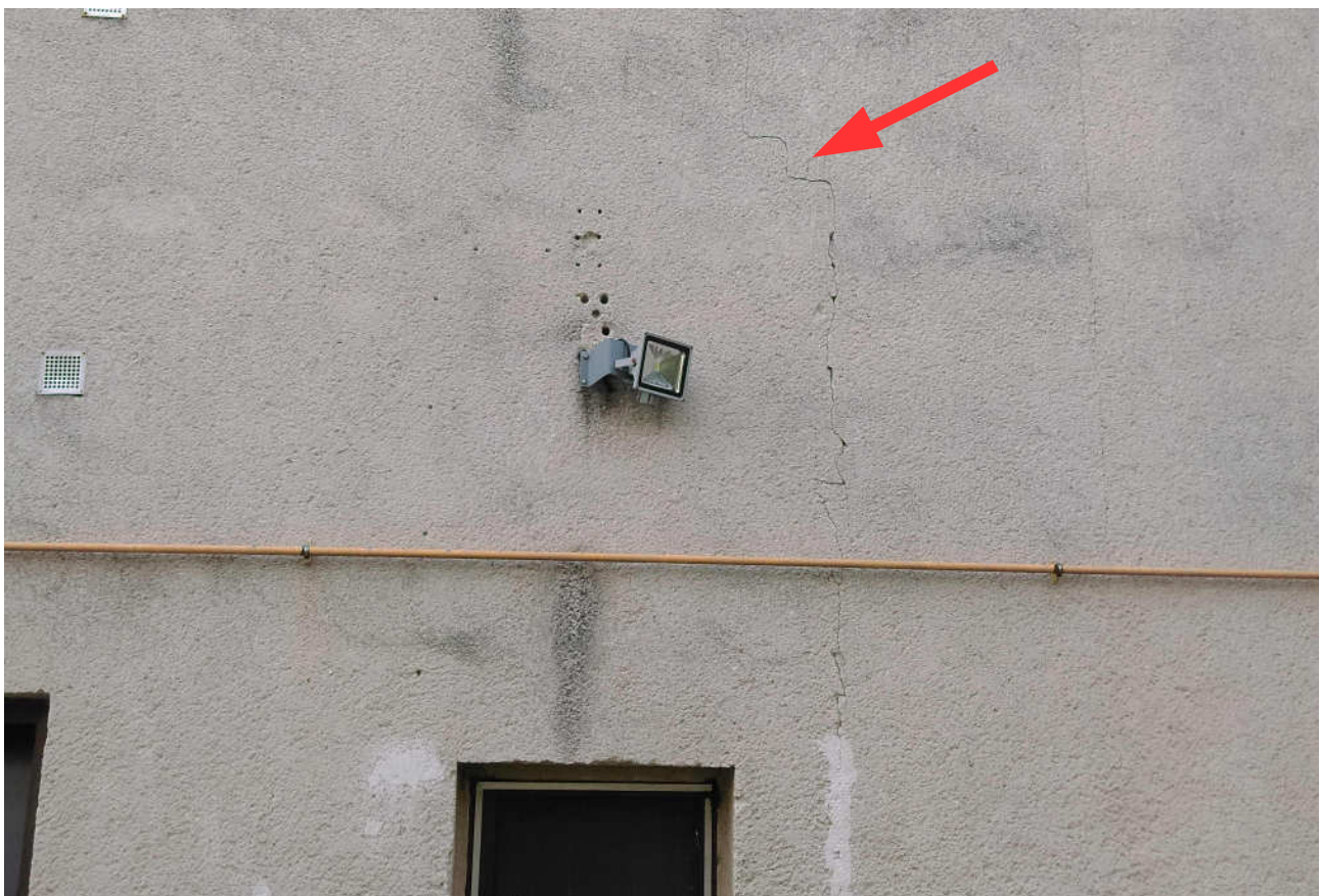
Lokálna trhlina v obvodovom murive, kopírujúca ložné a styčné škáry tehál
