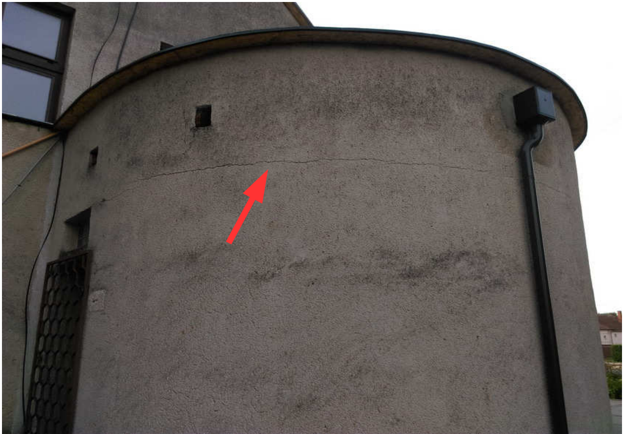
Trhlina na rozhraní železobetónového венca a muriva
