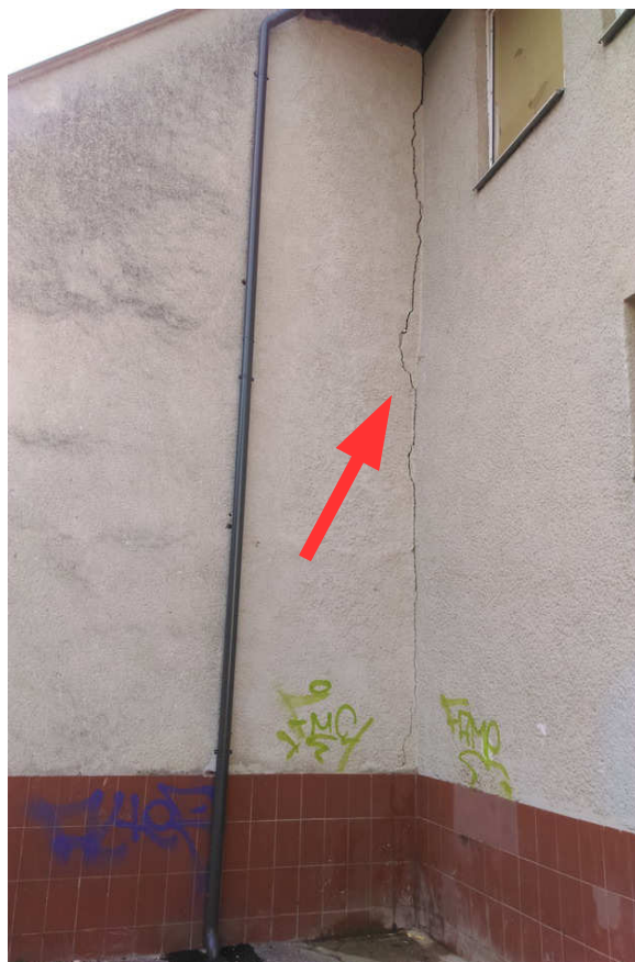
Trhlina medzi objektom kultúrneho domu a samostatnou stenou
