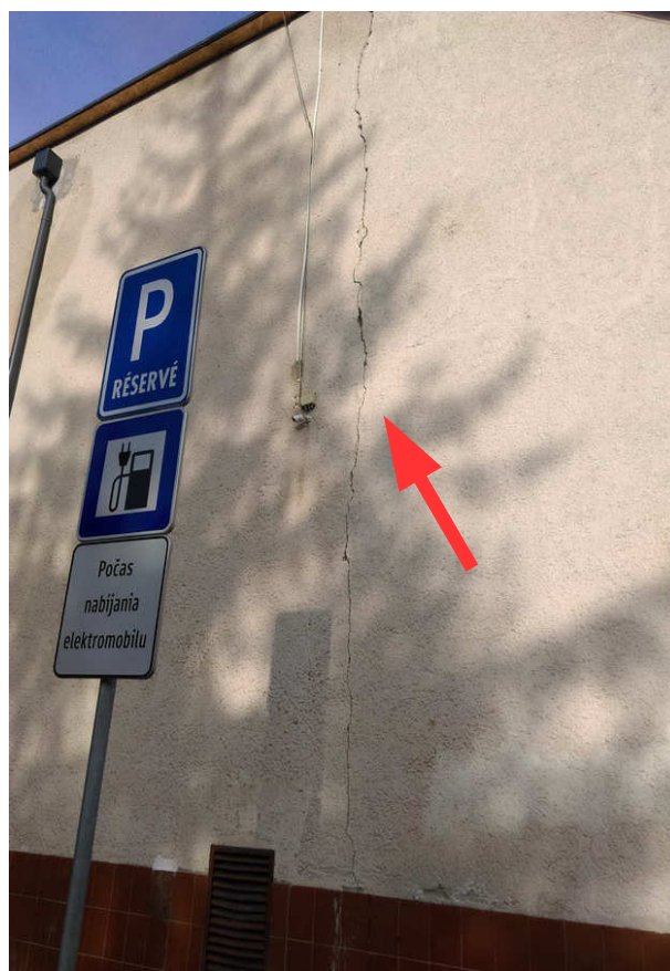
Trhlina medzi objektom kultúrneho domu a samostatnou stenou
