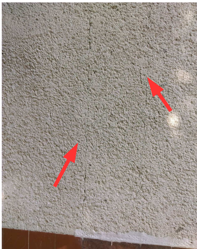
Charakteristické dilatačné trhliny medzi železobetónovými stĺpmi a murivom
